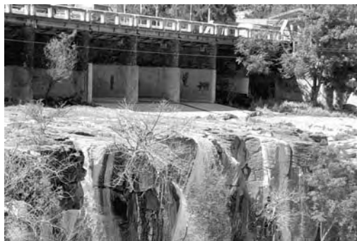
PUENTE Y CASCADA
