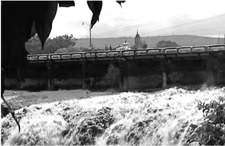
VISTA DE CASCADA, PUENTE Y PUEBLO DE JUANACATLÁN
