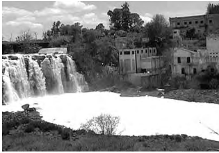
INSTALACIONES DE LA HIDROELÉCTRICA
