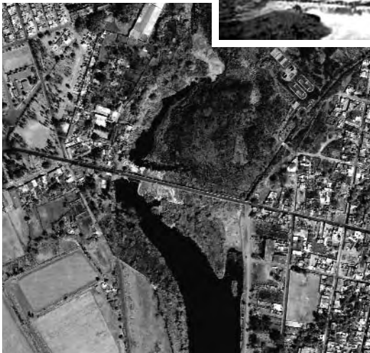
VISTAS AÉREAS DE LA CASCADA Y EL PUENTE
