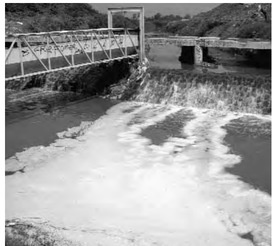
CANAL ARROYO SECO
