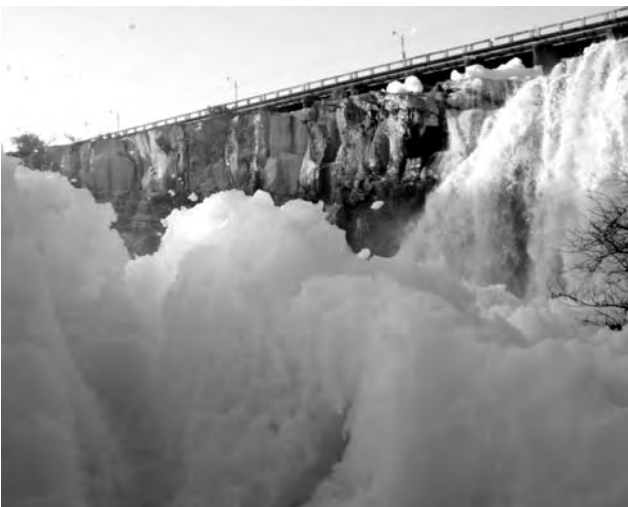
VISTA DEL PUENTE Y LA CAÍDA
