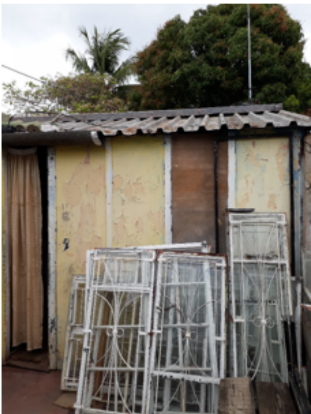
Maisons en amiante de la Cité EDC
