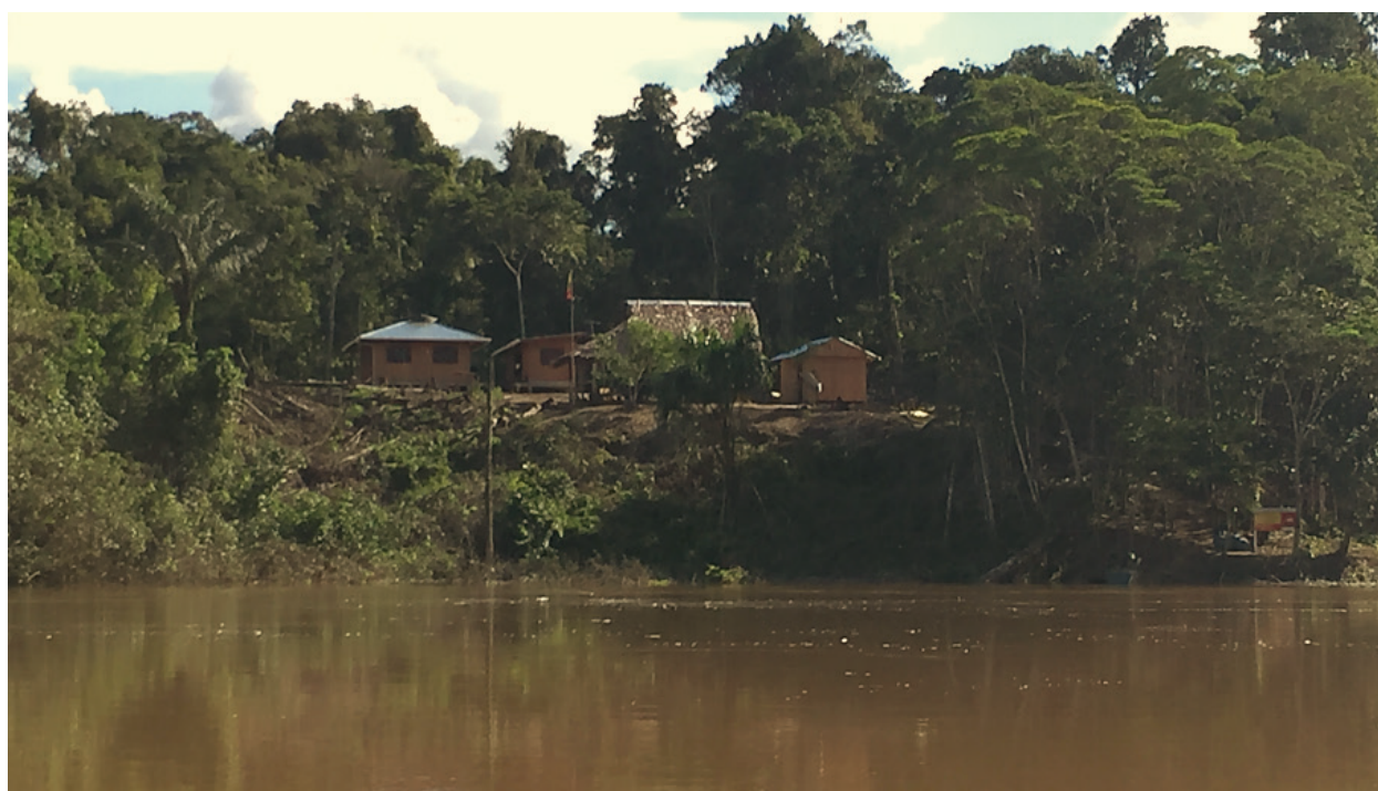
Figura 7. Cabaña de control y vigilancia Puerto Franco Parque Nacional Natural Río Puré, ubicada sobre la margen izquierda del río Puré en la frontera con Brasil
